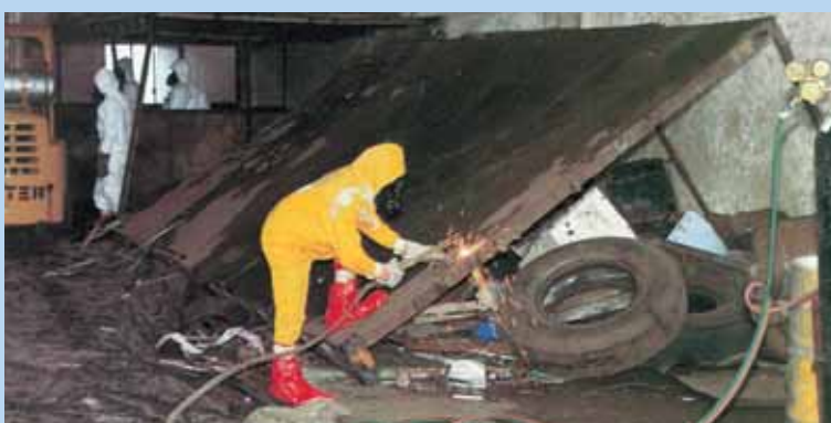
Fotografía de la portada: Corte de partes contaminadas para trasladarlas fuera del almacén de un parque de chatarra. Cortesía: CNEN/Brasil.
